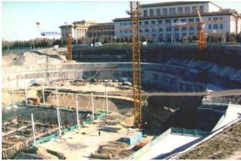
国家大剧院地基工程
